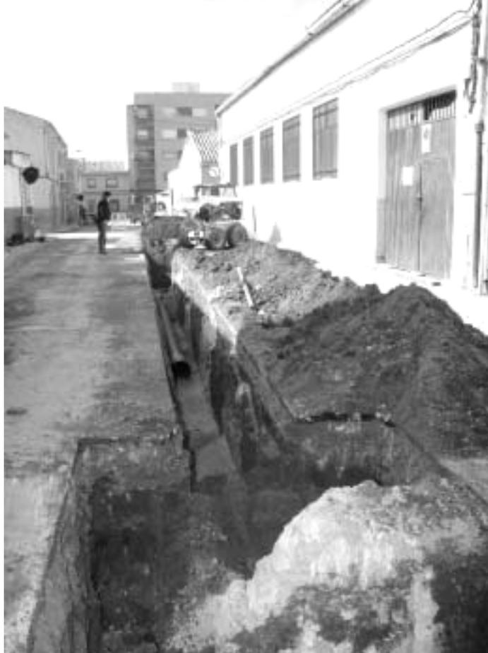
ZANJA ABIERTA EN LA CALLE OLÓZAGA PARA LA RENOVACIÓN DE LA RED DE ALCANTARILLADO
